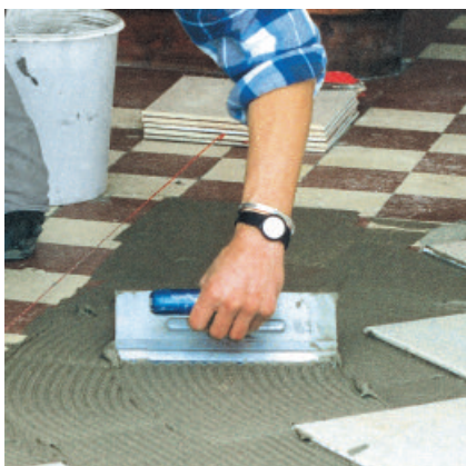
Nach ca. 30 bis 45 Minuten können nachfolgende Oberbeläge mit PCI-Fliesenklebern aufgebracht werden.
